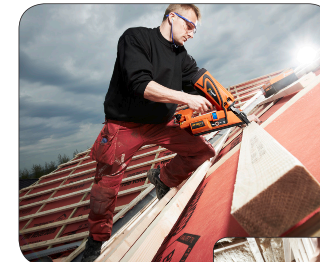
Krycie dachu – łąty, kontrłaty
