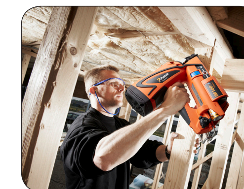
Montaż konstrukcji ramowych drewnianych
